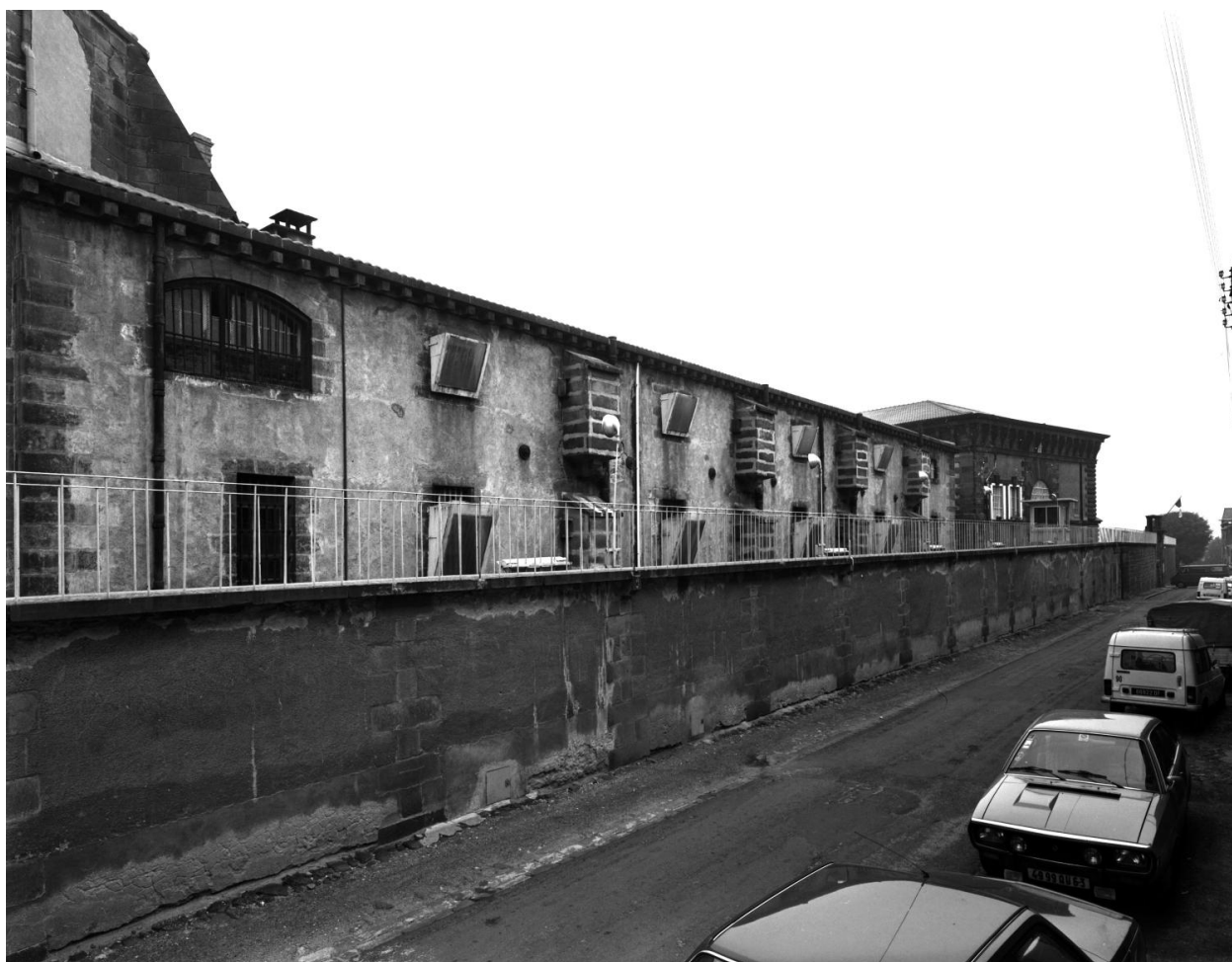
Vue générale, en 1984, du mur de clôture le long de la rue de l'Hôtel-des-monnaies ; élévation sud du bâtiment F d'origine (démoli dans les années 1980).
