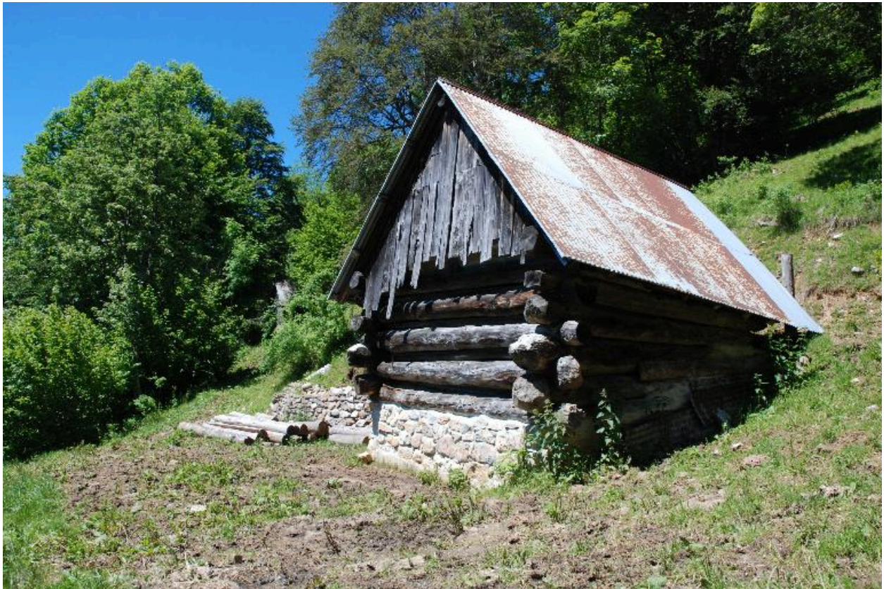
Vue d'ensemble côté aval.
