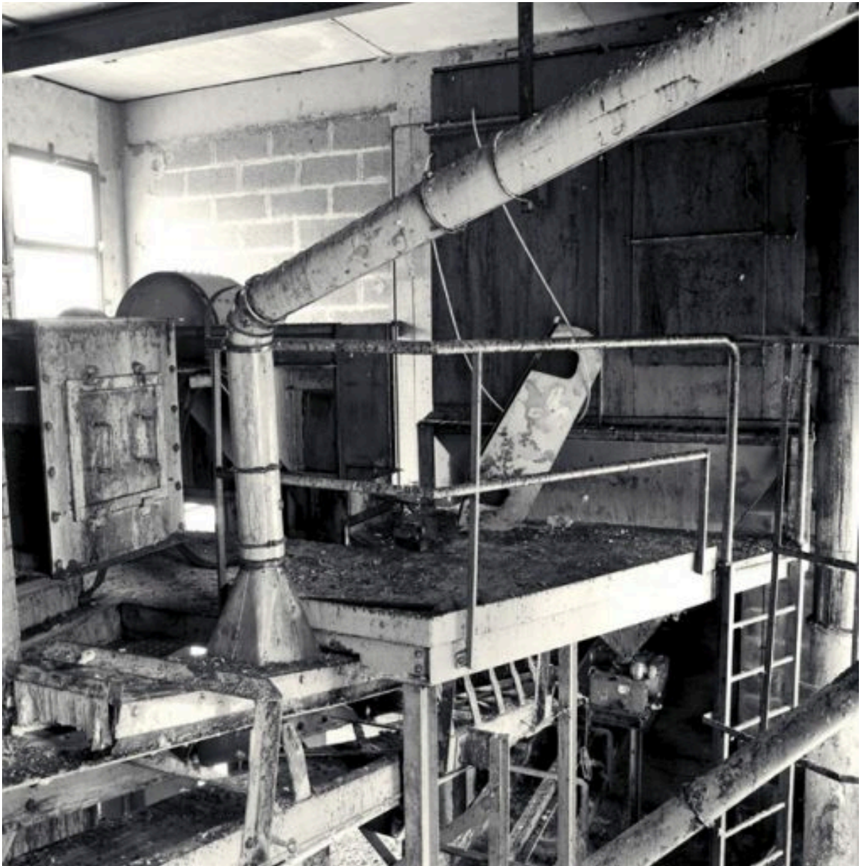
La cage des élévateurs : la passerelle des machines
