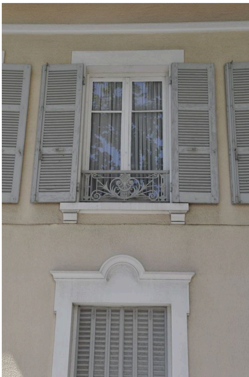
Baie centrale du premier étage
