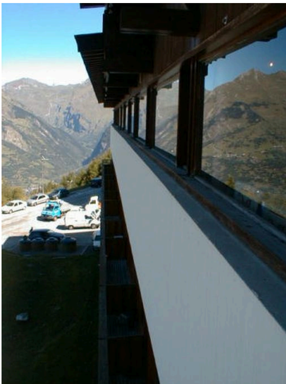
Arc 1600. Immeuble Pierre Blanche. Immeuble parallèle à la pente avec galerie latérale et coursive horizontale. Détail du balcon
