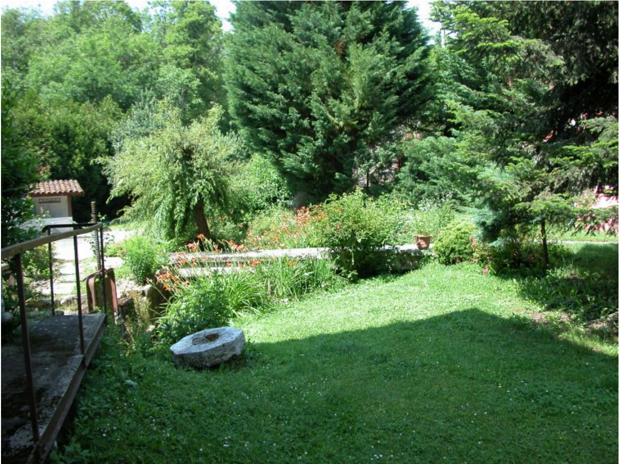
Vue d'ensemble du système de circulation d'eau et du ponton franchissant le bief.
