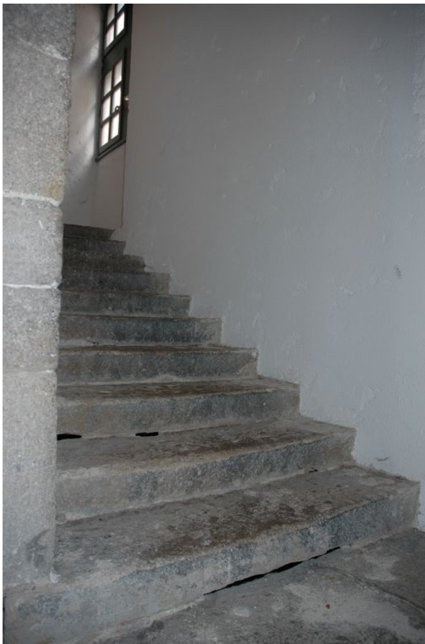
Escalier à mur noyau plein.
