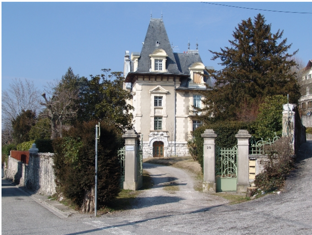
Vue d'ensemble depuis le portail
