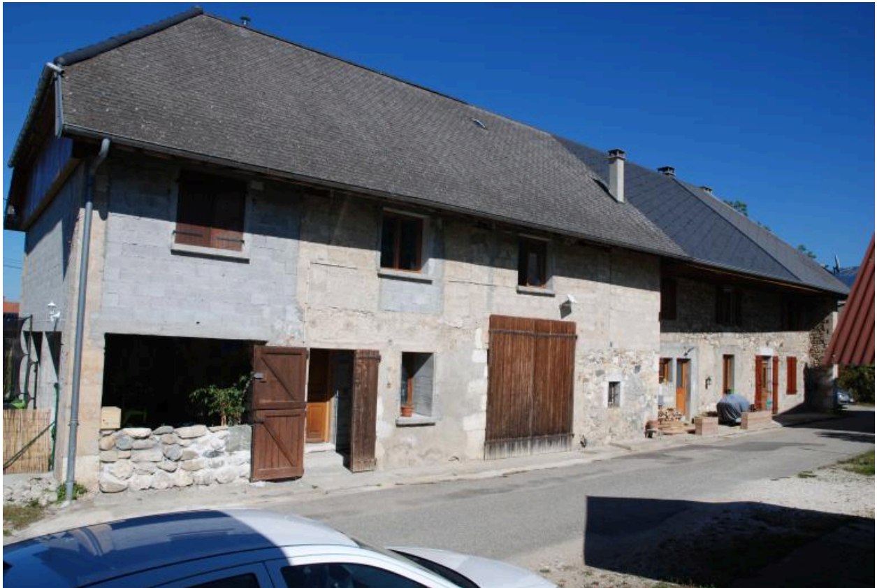
Ancienne ferme, transformée en habitations, dénaturée (2016 B2 985, 1819, 1820).
