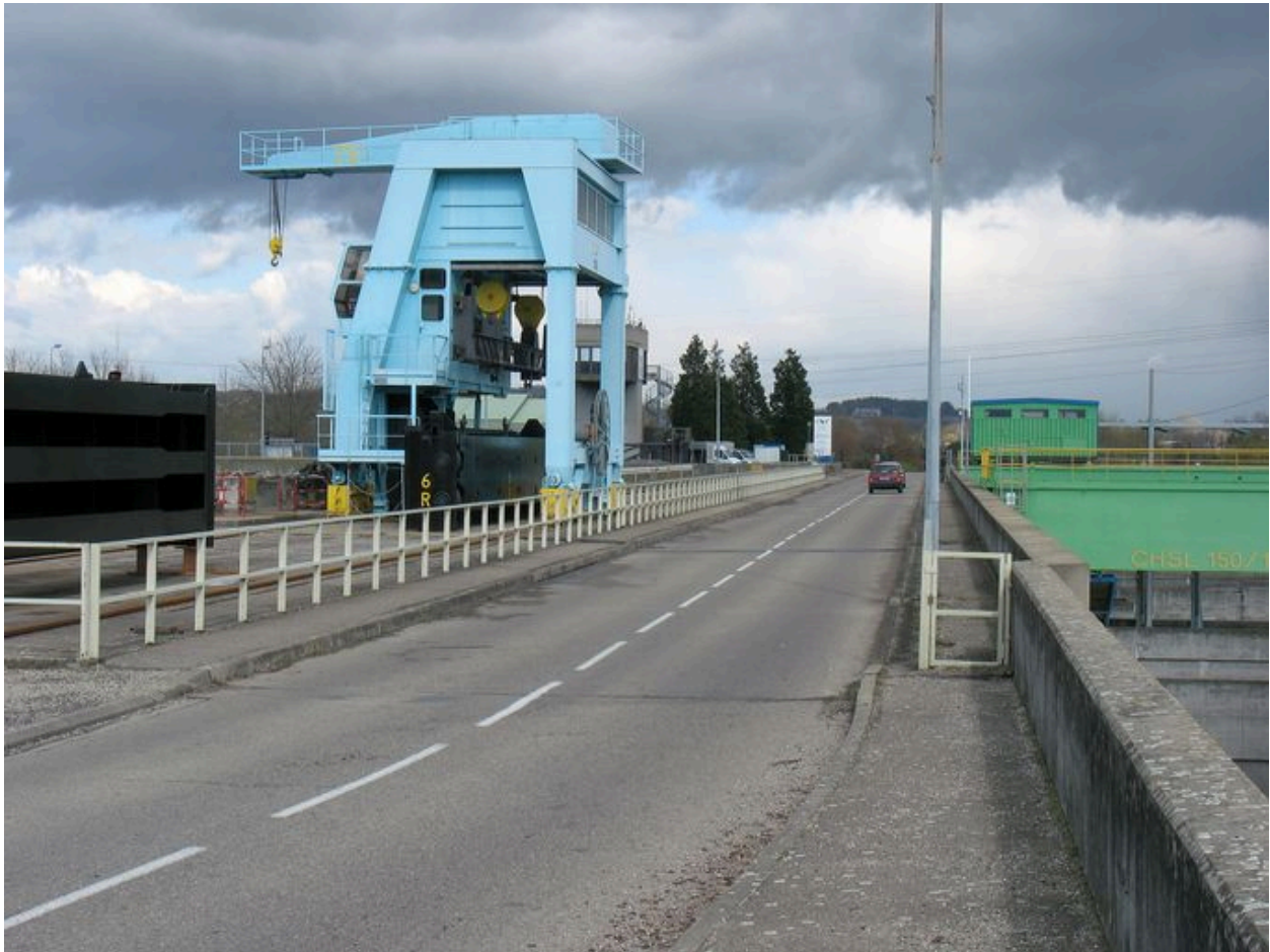
Vue de la chaussée du pont sur l'usine-écluse
