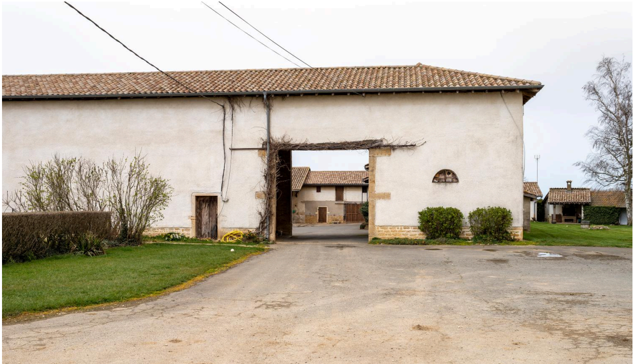
Vue extérieure depuis le sud, passage couvert traversant la grange
