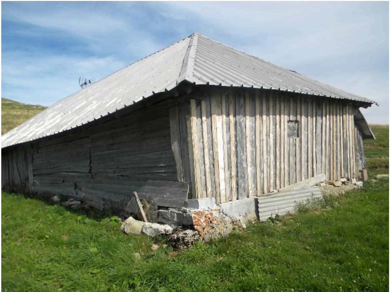
Vue de trois-quarts nord-ouest de l'ancienne étable.
