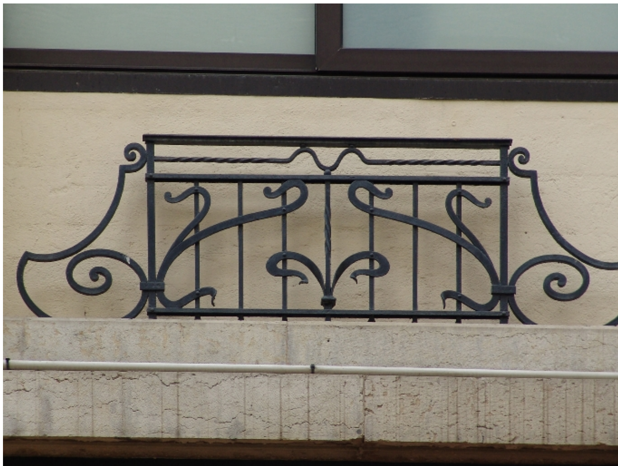
Détail de ferronnerie
