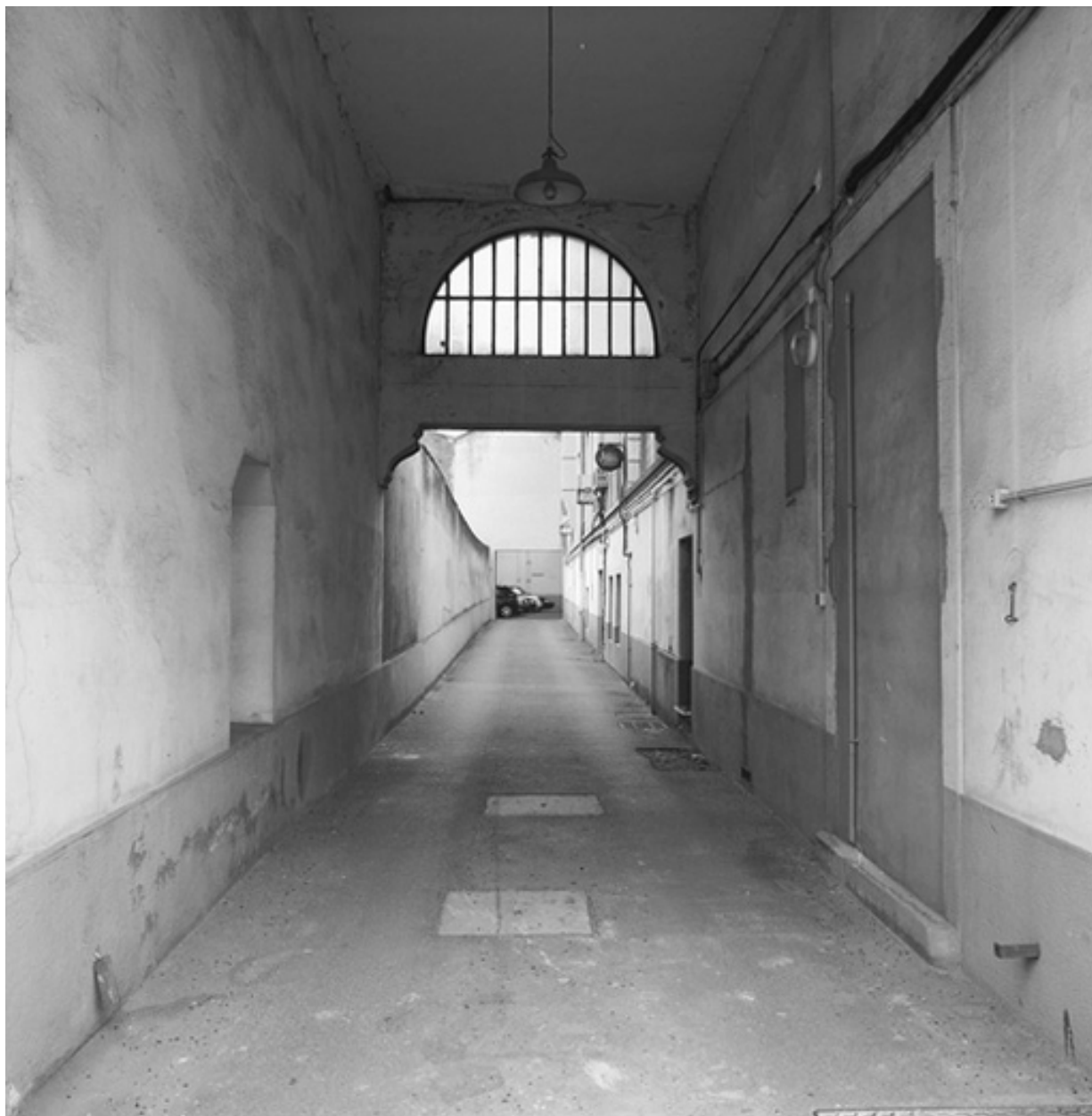
Détail passage traversant nord-sud
