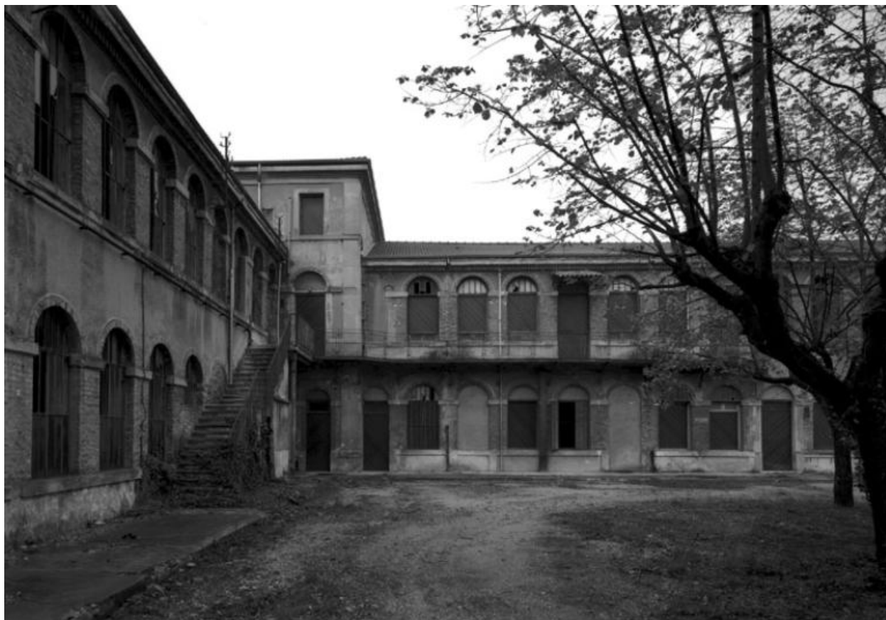
Vue est du bâtiment principal
