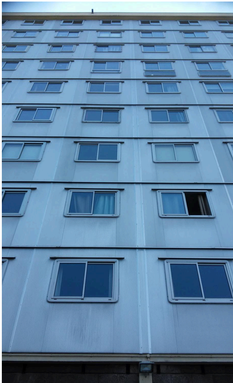
Façade nord de l'immeuble des Cèdres
