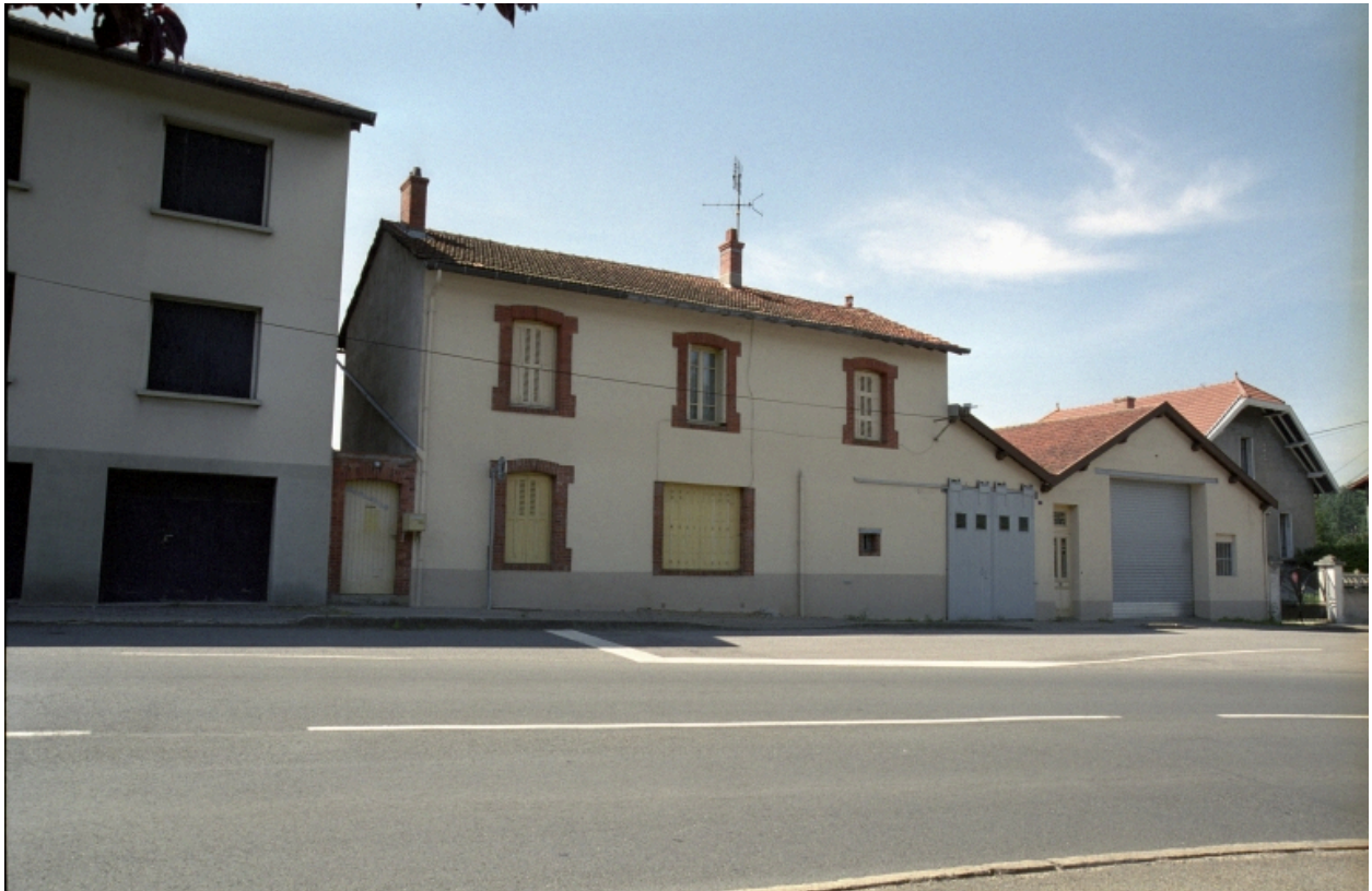
Boën, îlot 14, RN 89, 9 et 7. Vue générale de la façade sur rue.
