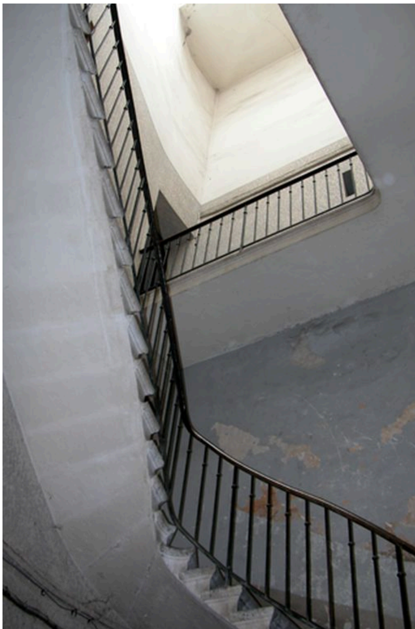
Cage de l'escalier desservant la partie est des logements
