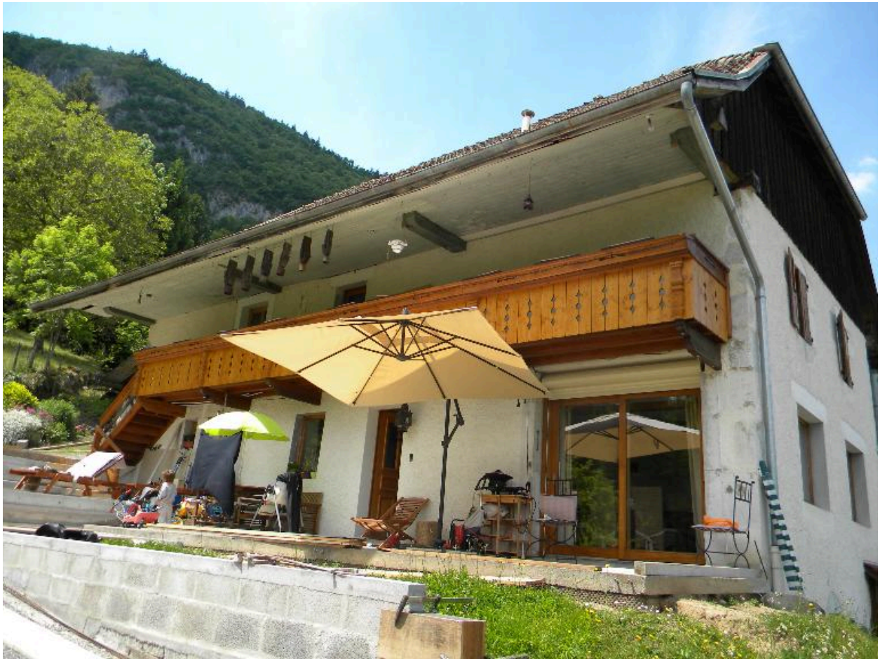
Vue de la façade sud d'une ancienne ferme (2008 B7 1163).
