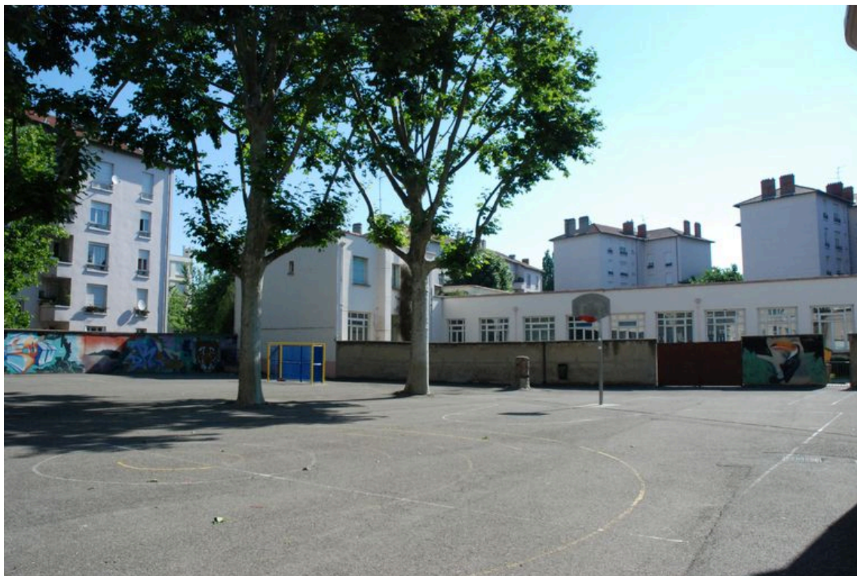
Mur de séparation Est, entre l'école primaire et la maternelle
