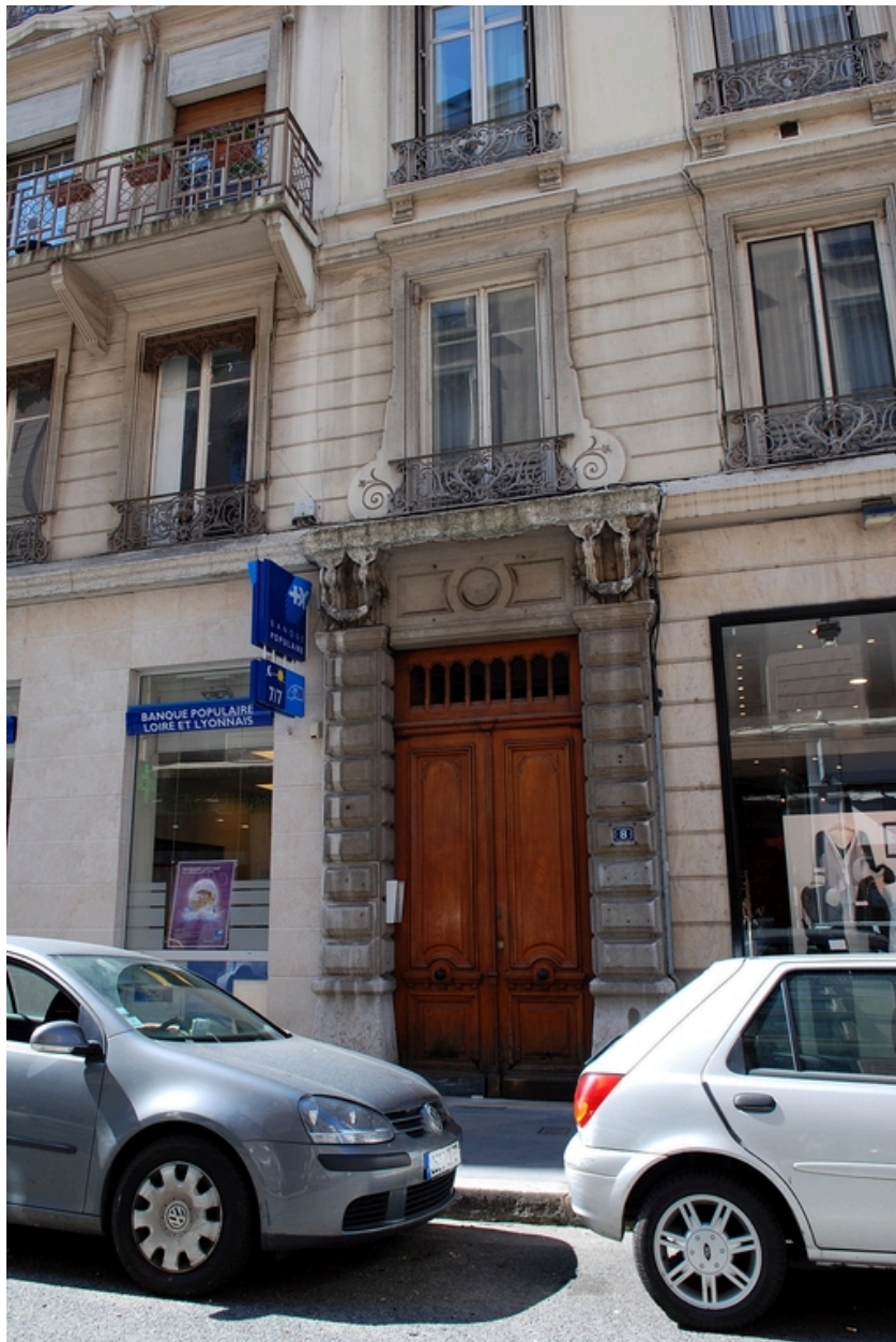
Elévation antérieure : la porte
