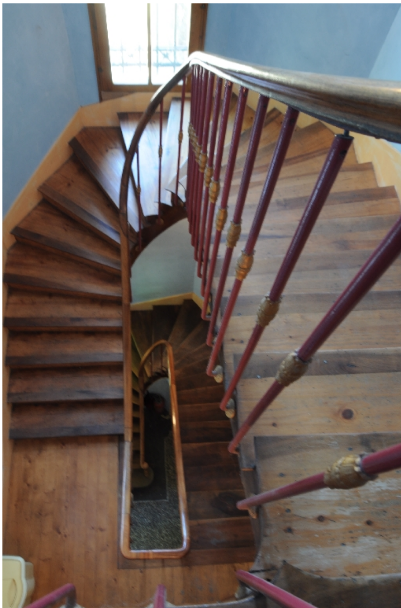
Escalier de la tour, vue par dessus
