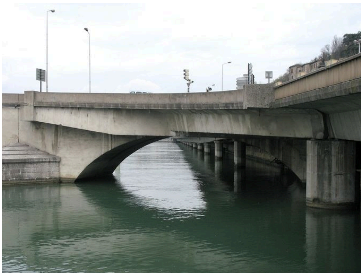
Travée de rive gauche, face aval
