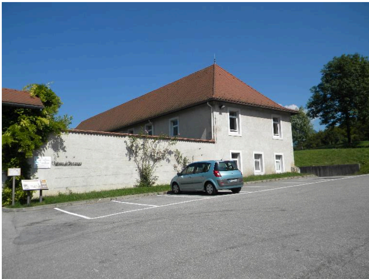
Vue de l'aile est depuis le parking.
