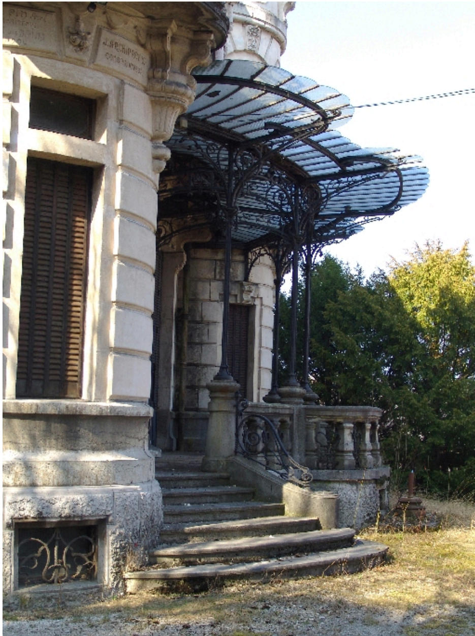
Côté gauche du perron nord
