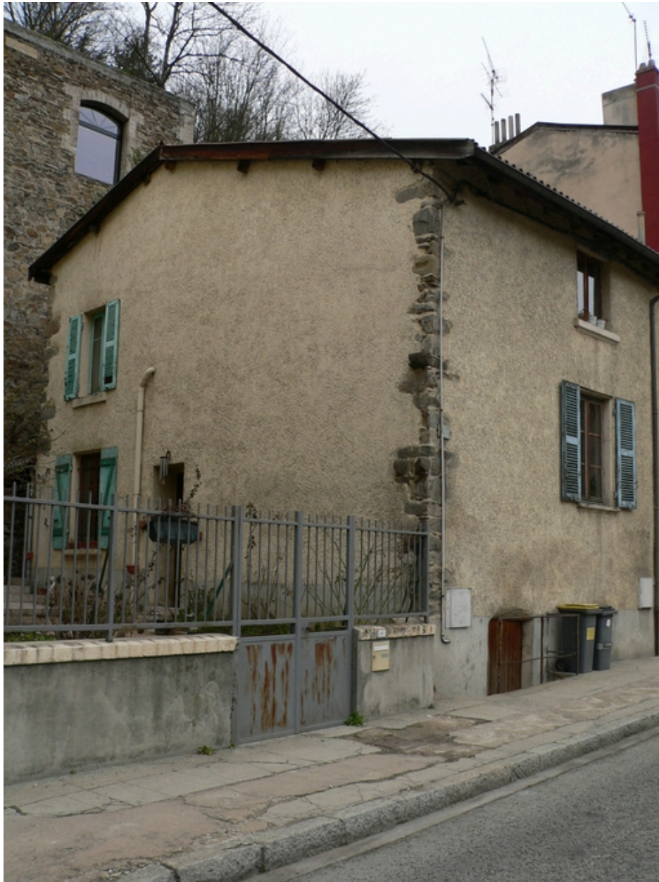
Façade sur rue et latérale gauche
