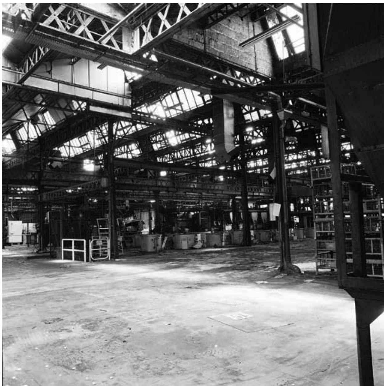
Usine moteur : ancien traitement thermique en cours de démontage.
