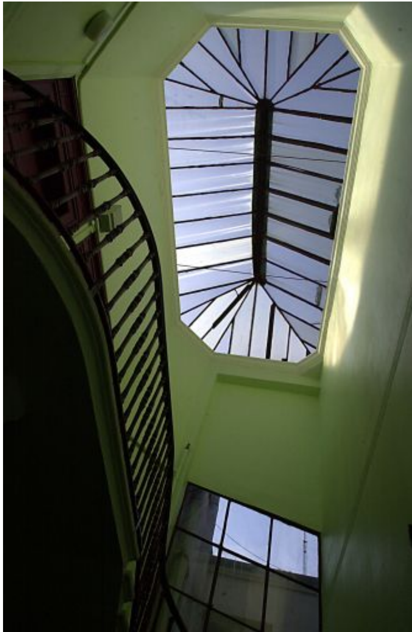
Escalier, vue intérieure de la couverture de la cage
