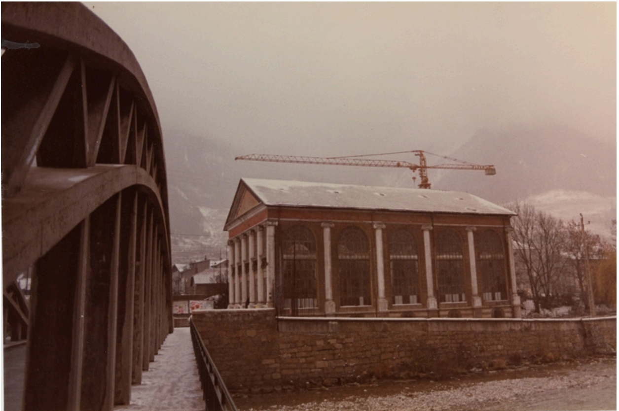
Vue d'ensemble nord-est
