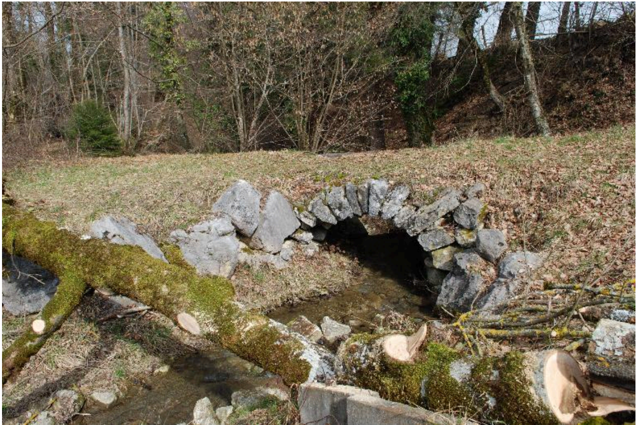
A1 1132 (vers, NC), Arandets (les), pont. Ancien petit pont au-dessus du ruisseau du Favant
