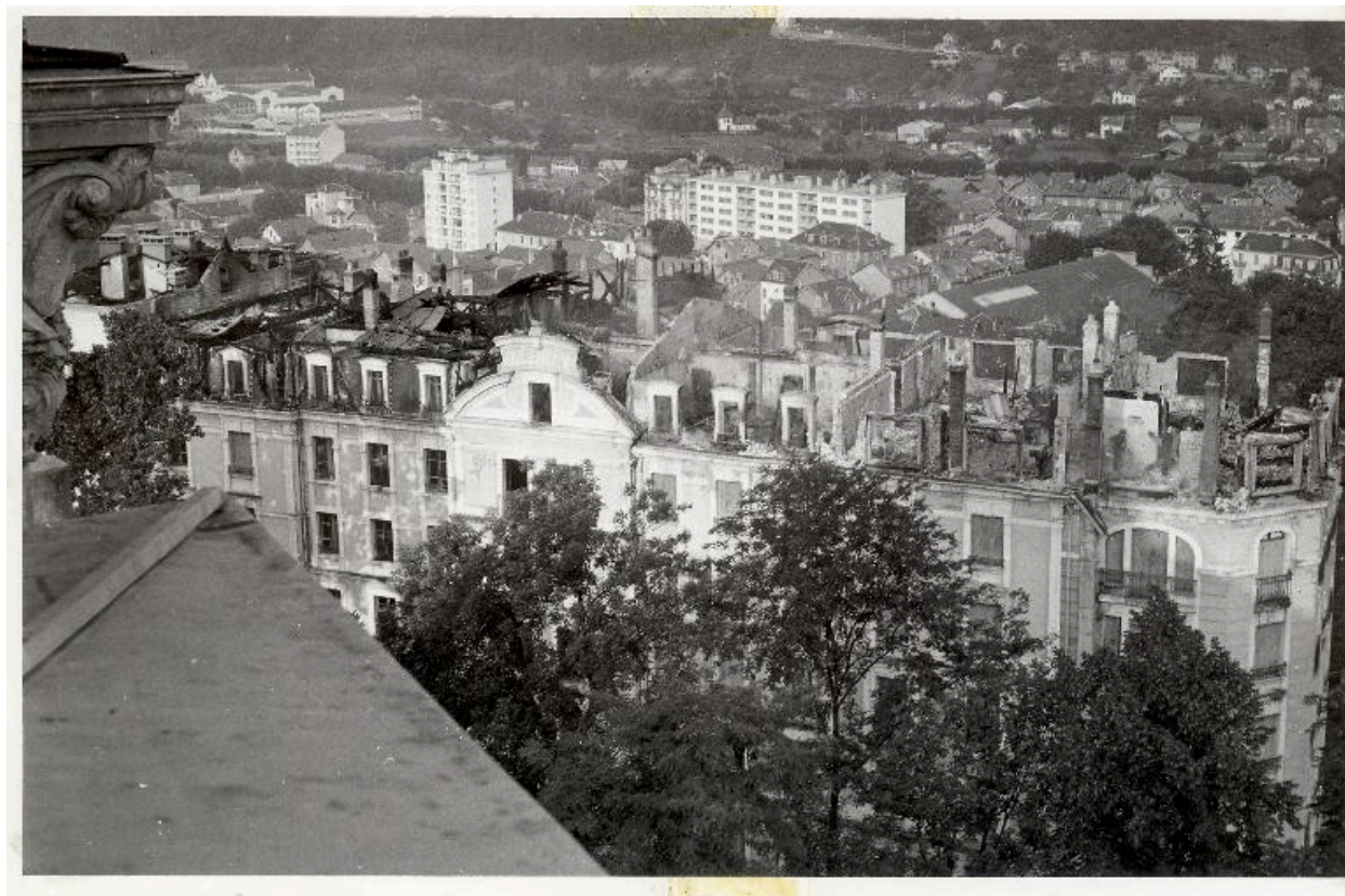
Façade est et toiture après incendie, 1963
