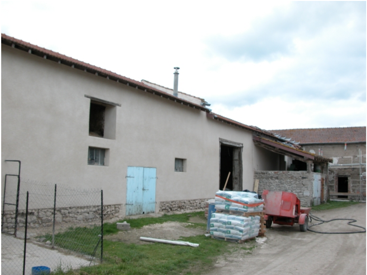
Vue de l'étable orientale, depuis le nord-est.
