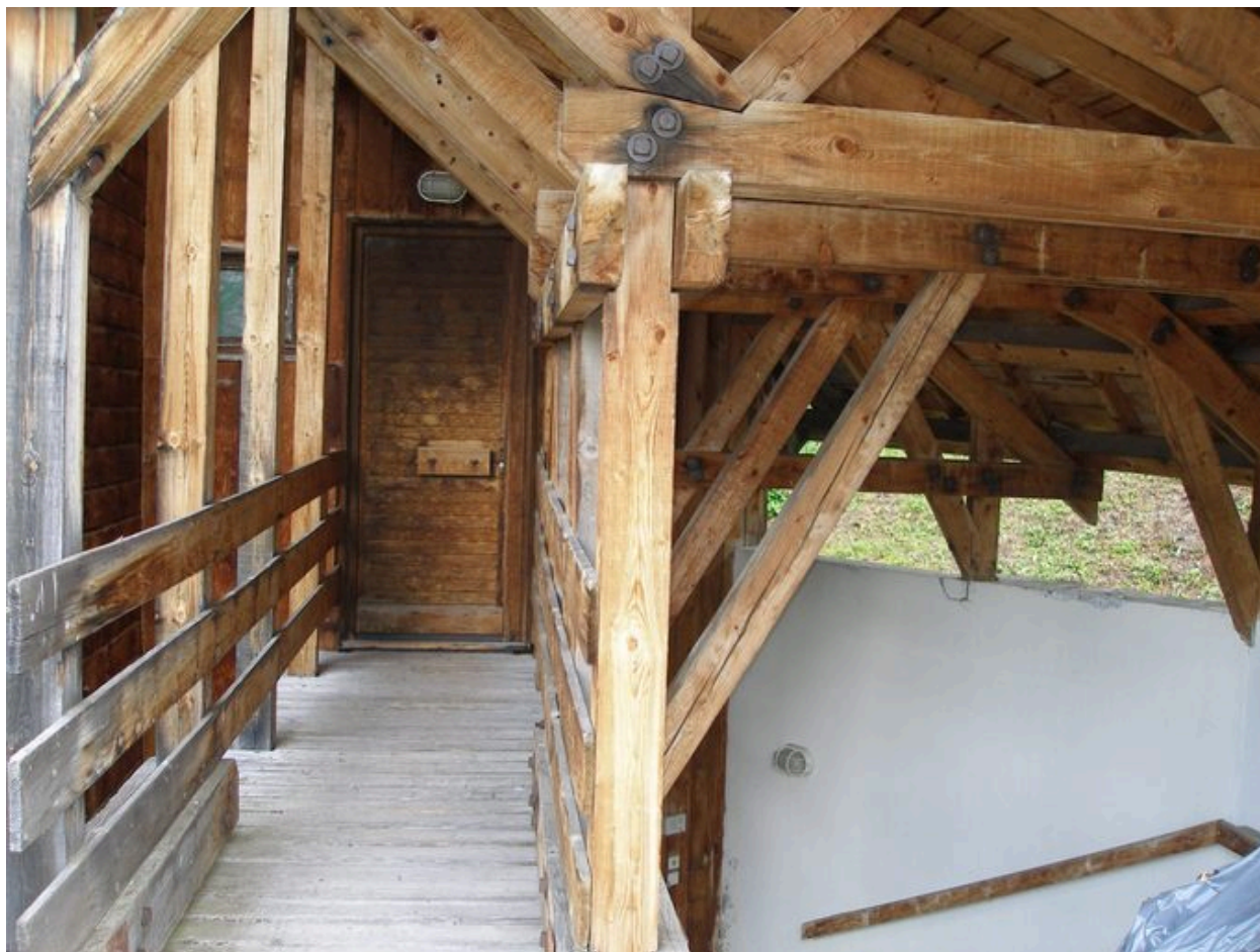
Vue d'ensemble de la galerie d'entrée
