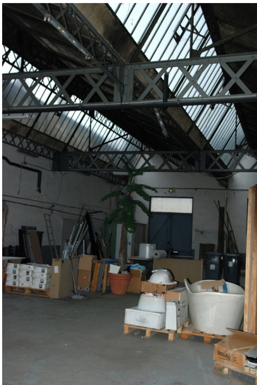
Vue d'ensemble atelier
