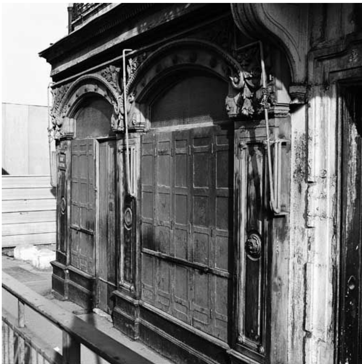
Façade principale, ouvertures de boutique à gauche de la porte
