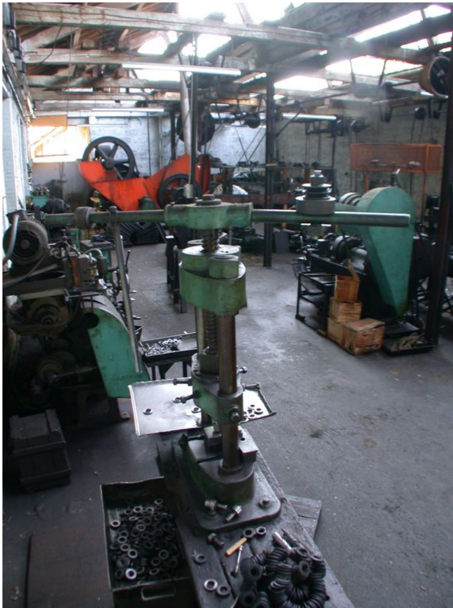
Matériel électrique, machines outils de l'atelier adjacent à l'ancienne salle de spectacle. Photo couleur, vers l'année 2000, AP S. Chalencon
