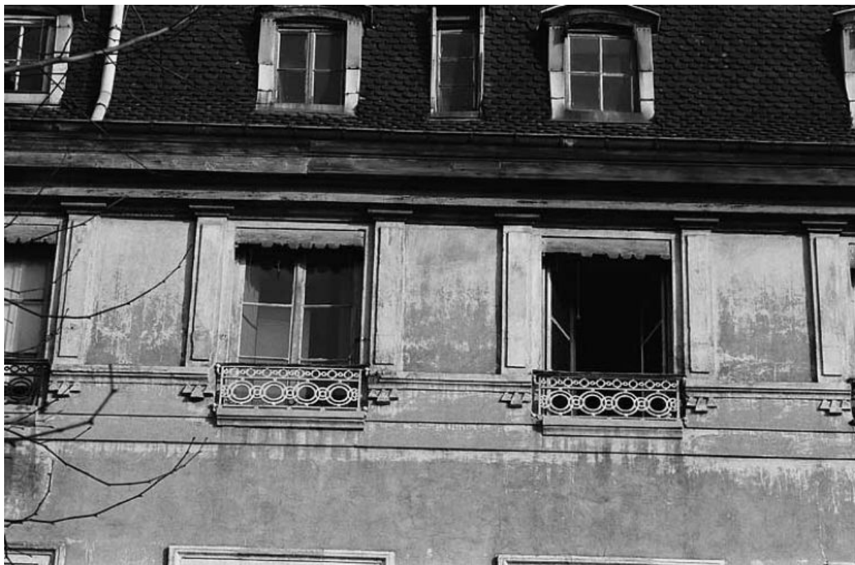
Façade principale, fenêtres de l'étage attique
