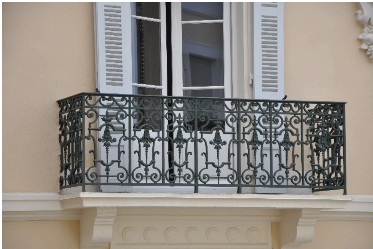
Balcon du 4e étage, façade nord
