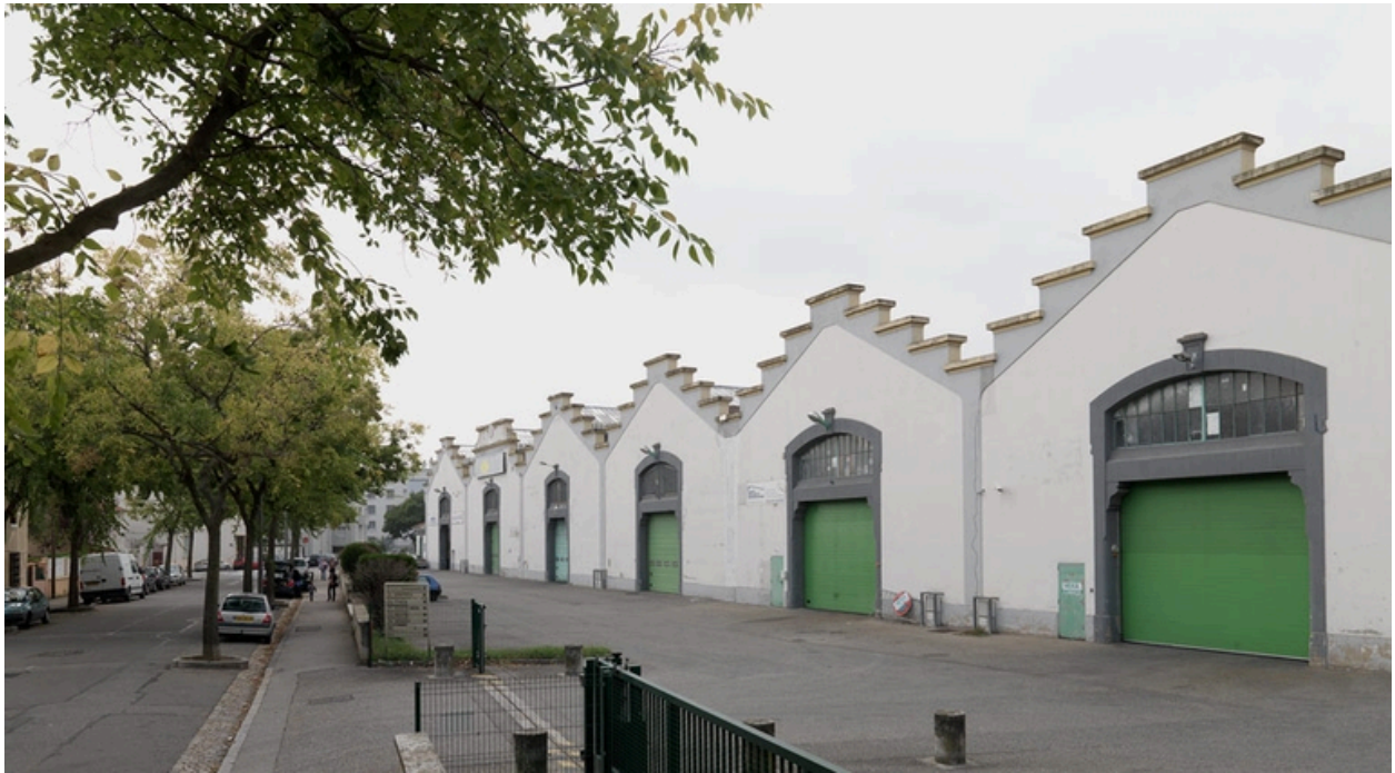
Vue d'ensemble nord
