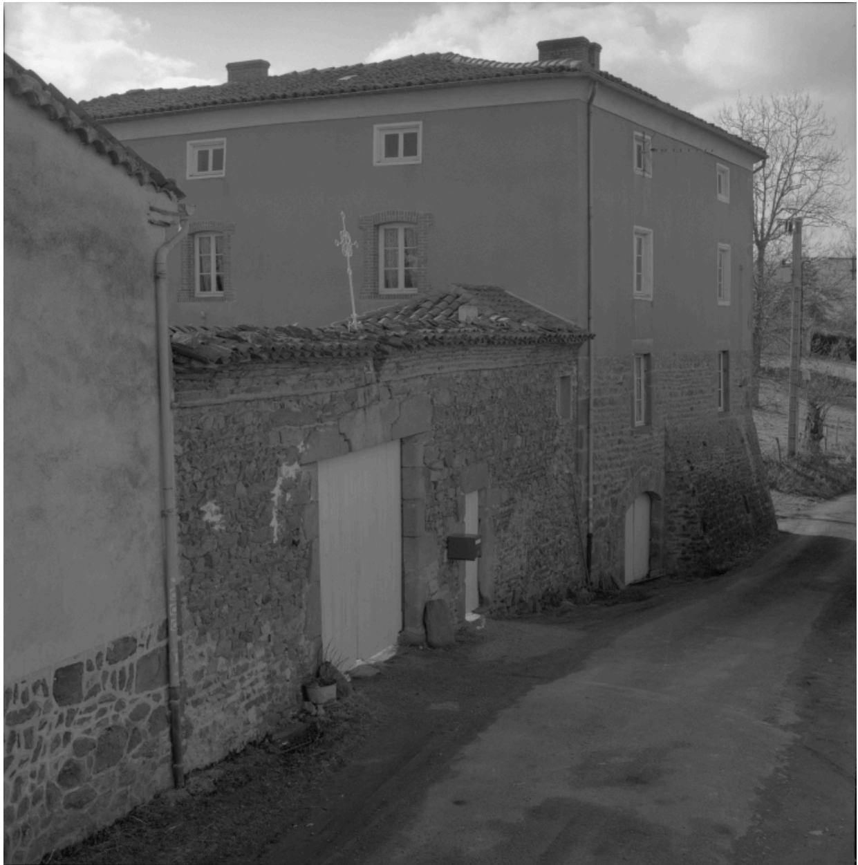
Vue du portail et du logis, depuis le sud-est.
