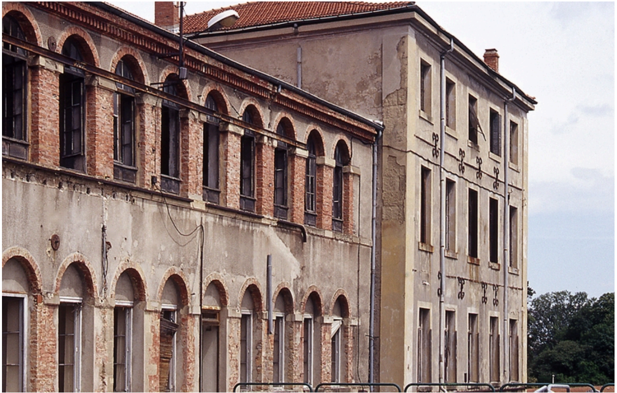
Vue sud-est pavillon nord
