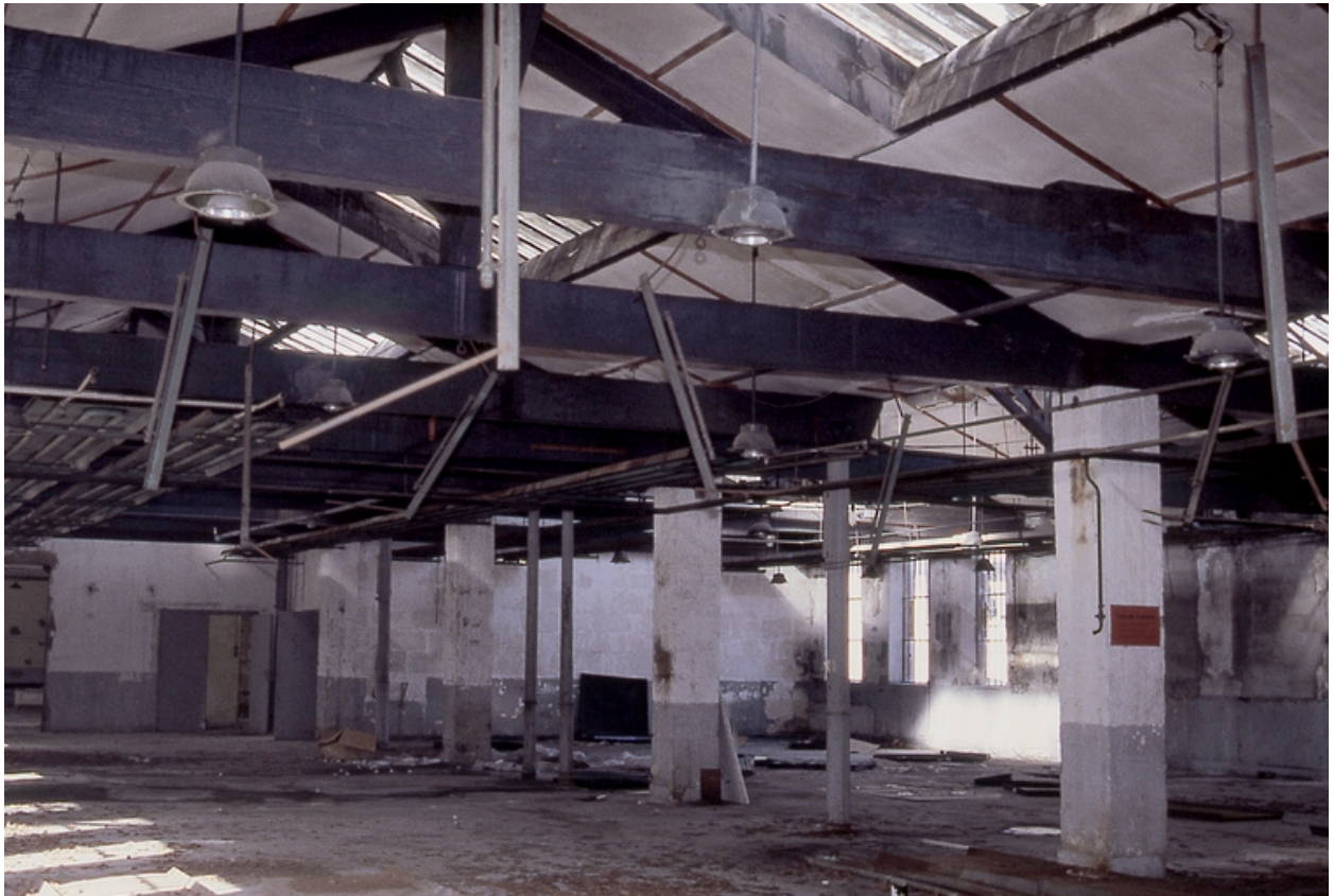
Charpente en vois
