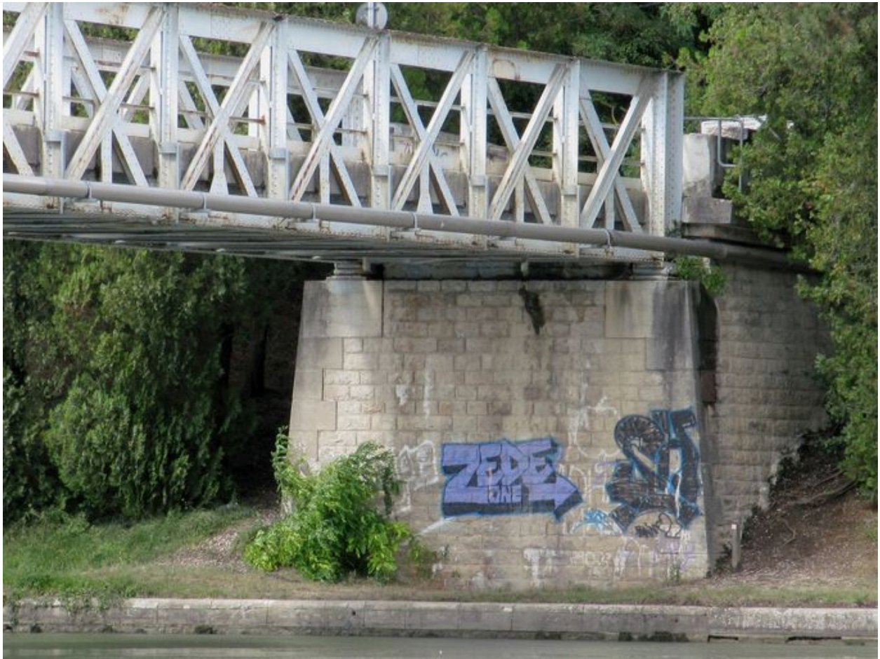
Culée droite, face amont, vue générale (depuis la rive gauche)
