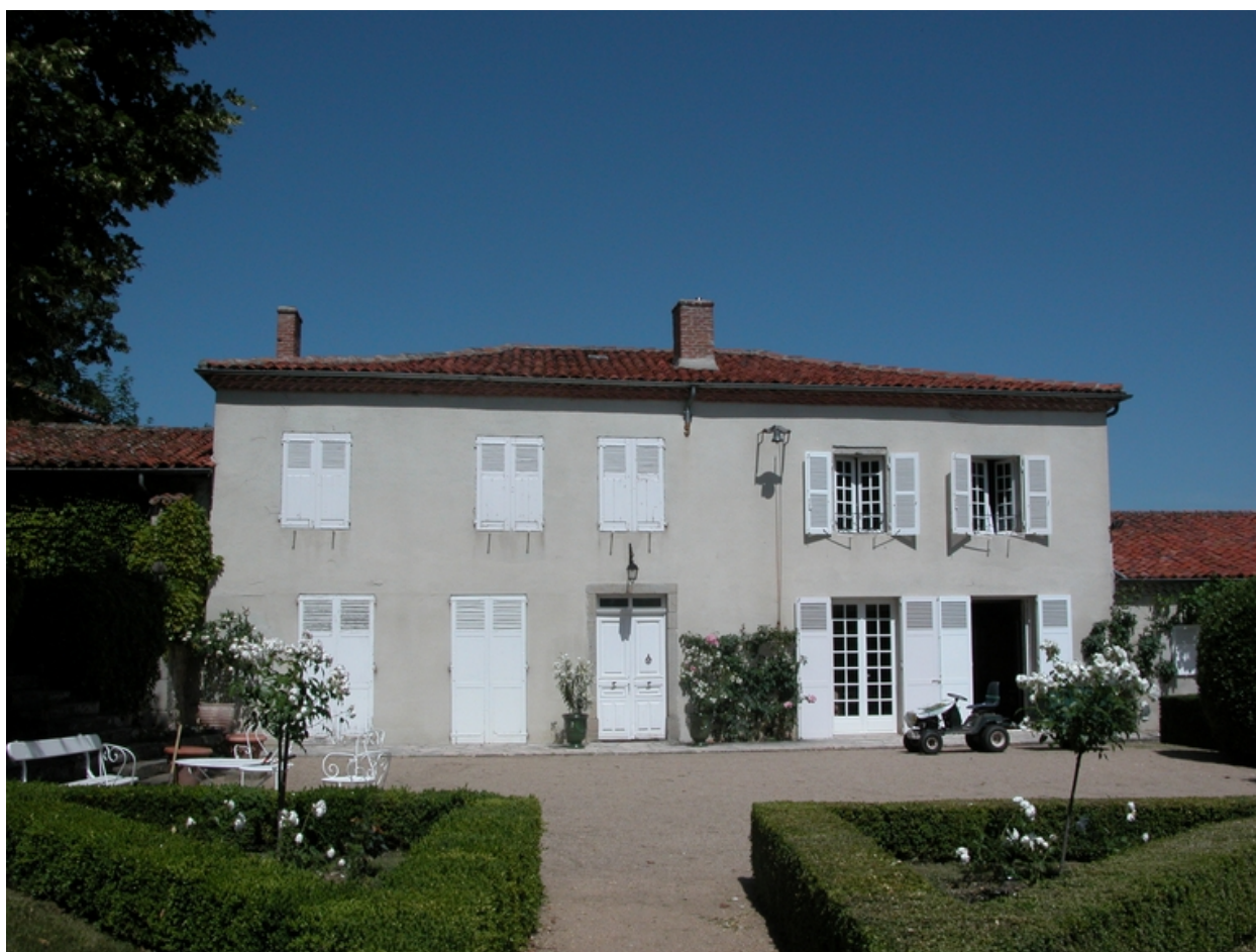
Vue d'ensemble du logis principal.
