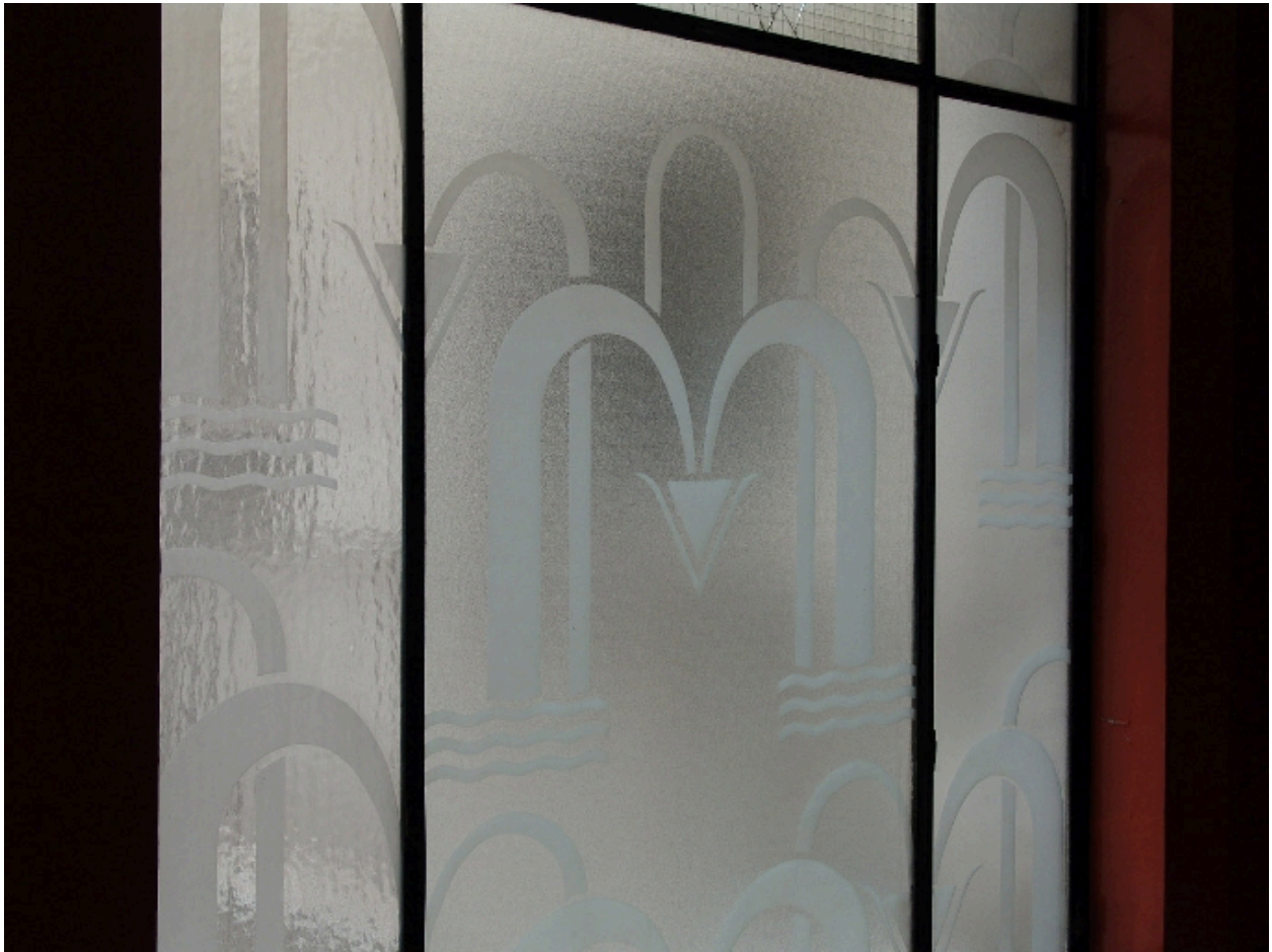
Verrière sur cour intérieure au rez-de-chaussée surélevé
