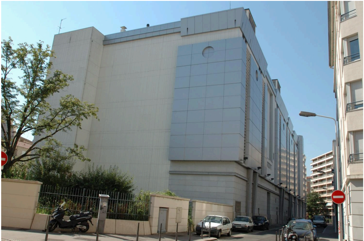
Poste de transformation Saint Amour.
