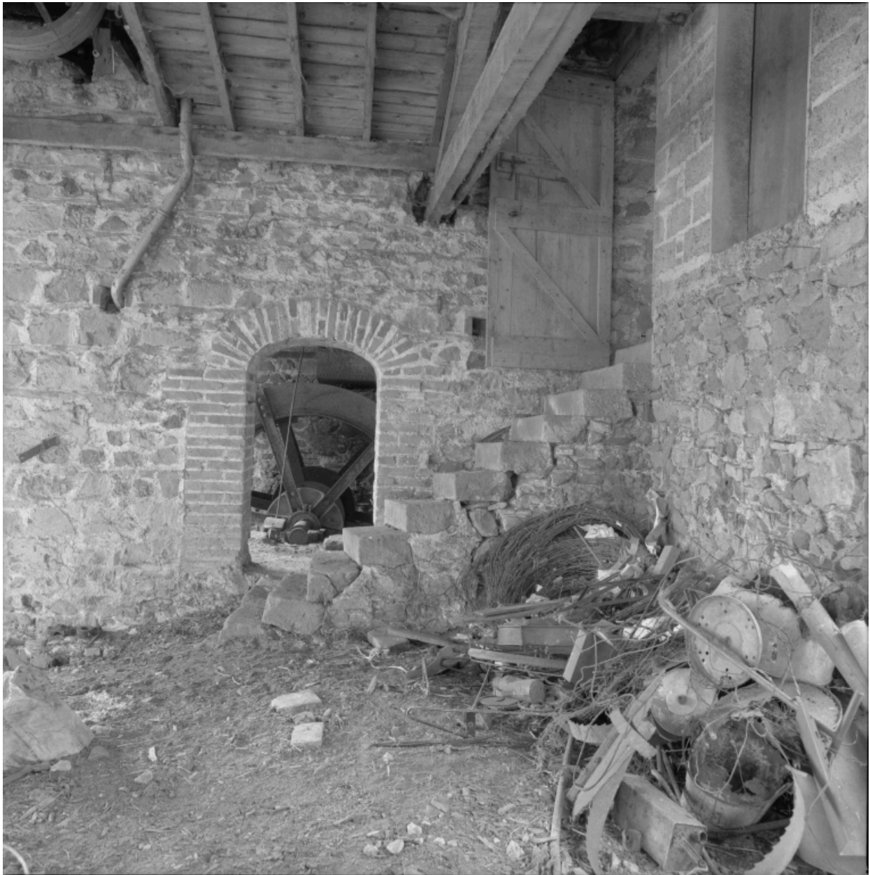
Elévation nord du moulin, escalier conduisant à l'atelier et ouverture d'accès à la roue hydraulique métallique.
