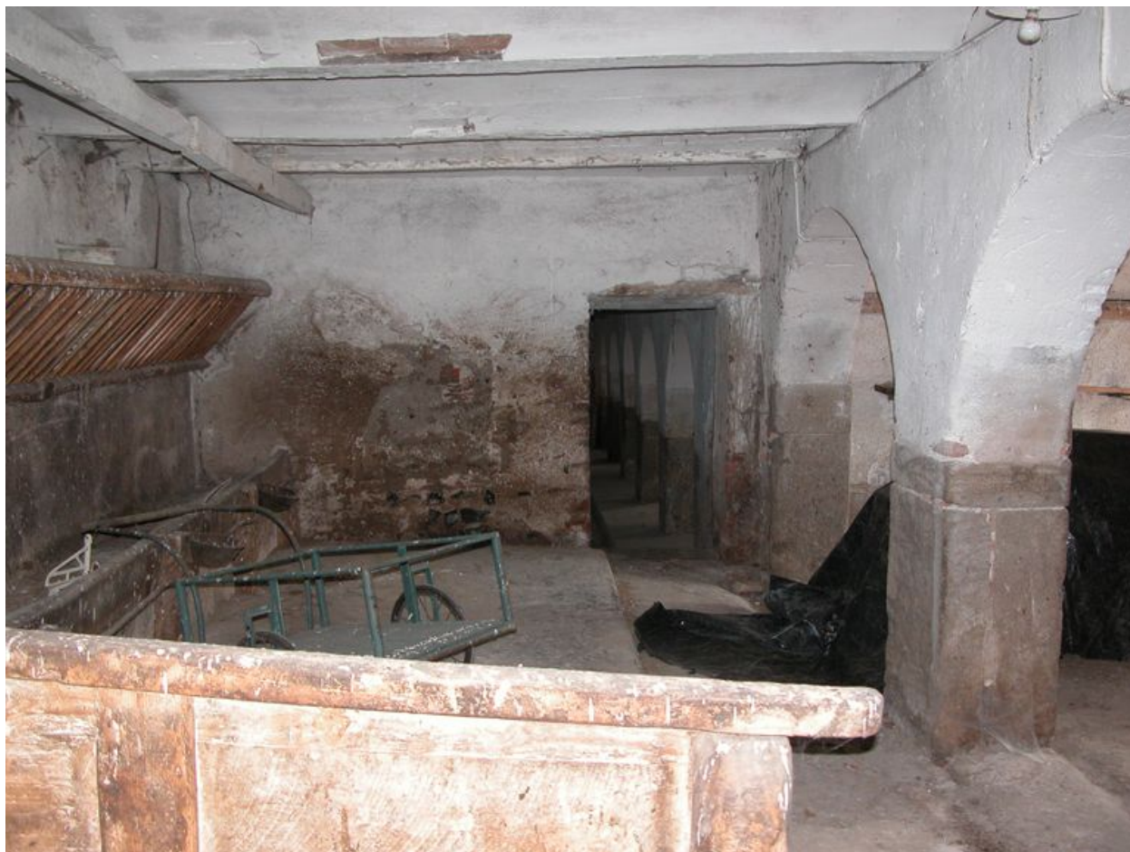
Vue intérieure de l'étable (partie ouest), depuis l'est.
