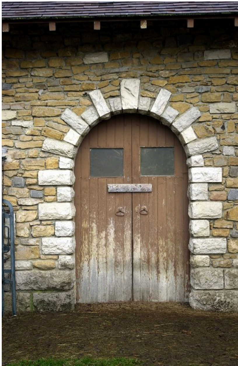
L'enclos des mouflons : détail d'une porte du bâtiment A 19
