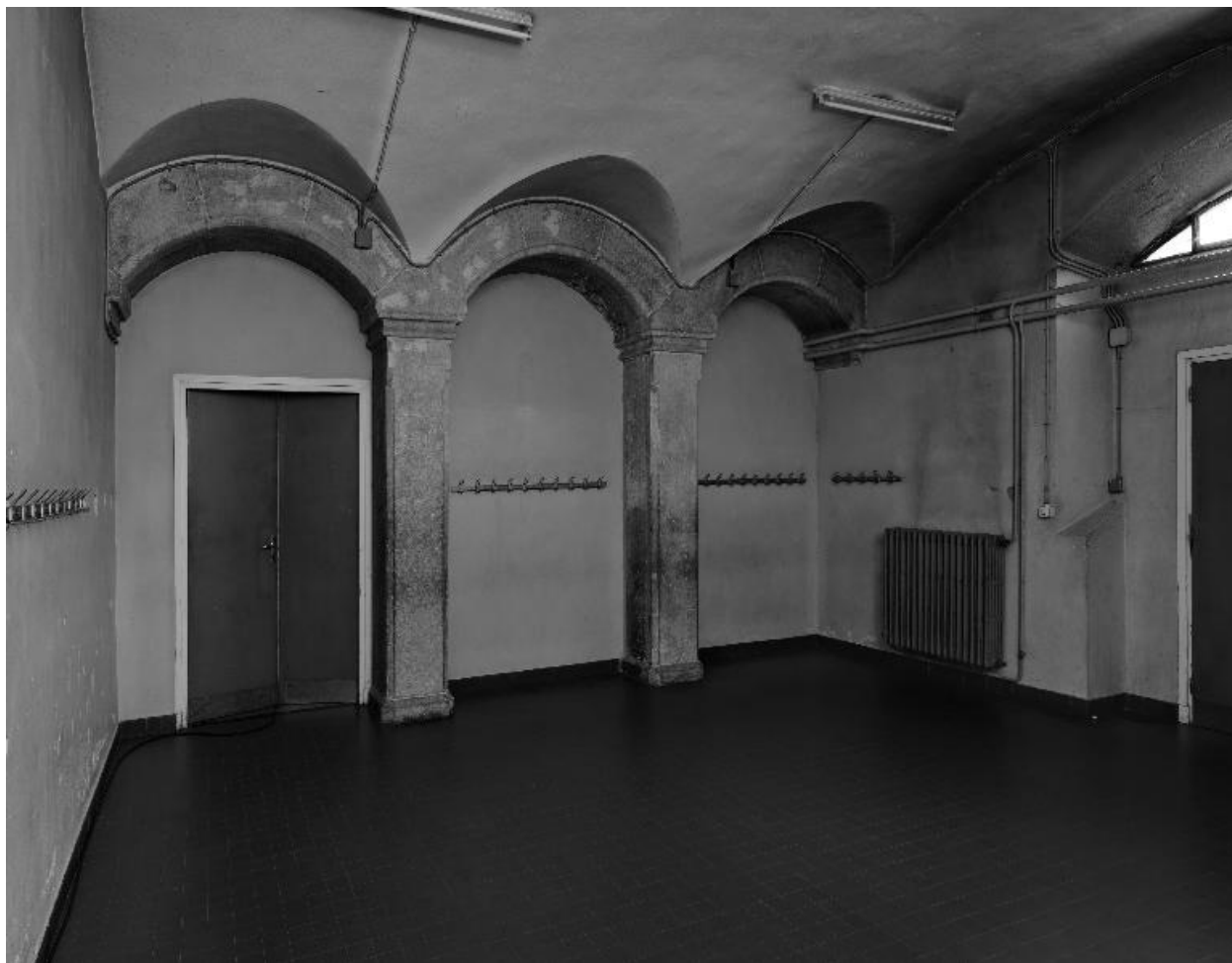
Corps de bâtiment nord-est, étage de soubassement : 2e salle voûtée
